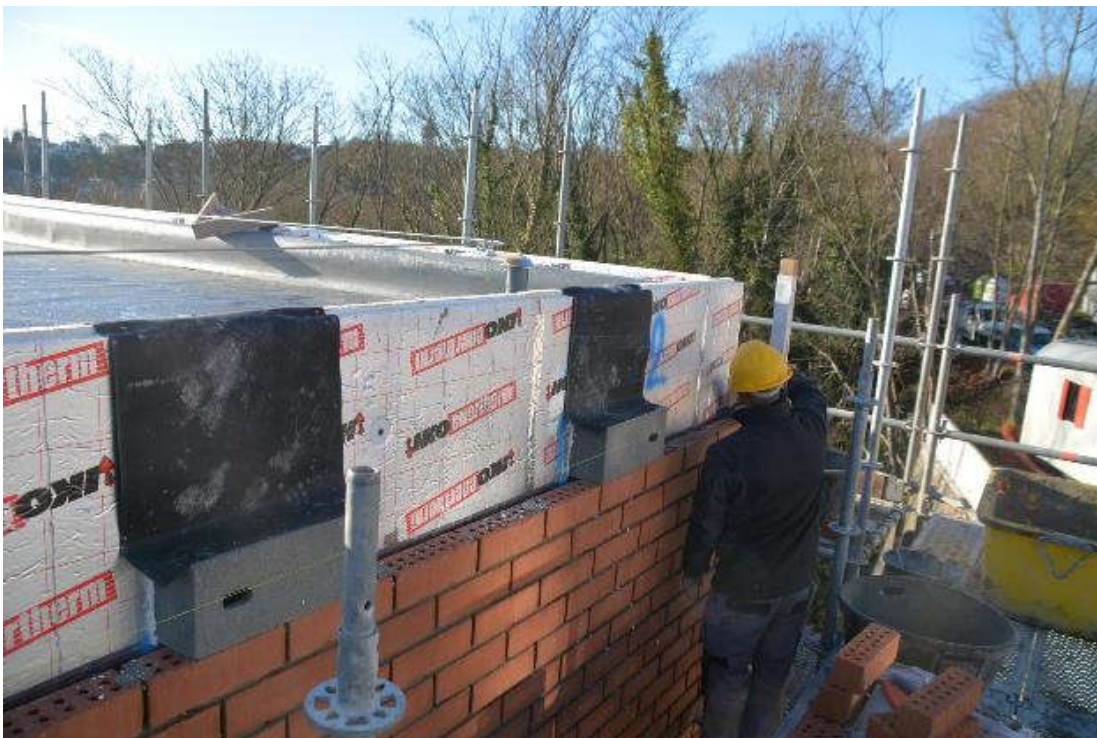
På liknande sätt, med bakomliggande isolering, integreras här holkstenar i fasaden av en byggnad med platt tak, längst uppe strax nedanför takkanten. Belgien. Foto: M. Vandurme.
