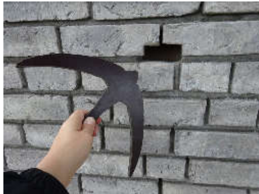
Här integreras en holksten i fasaden med bakomliggande isolering. I färdiga fasaden syns knappt inflygningshålet. Belgien. Foton: Martine Wauters.
