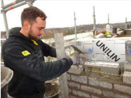
Här integreras en holksten i fasaden med bakomliggande isolering. I färdiga fasaden syns knappt inflygningshålet. Belgien. Foton: Martine Wauters.
