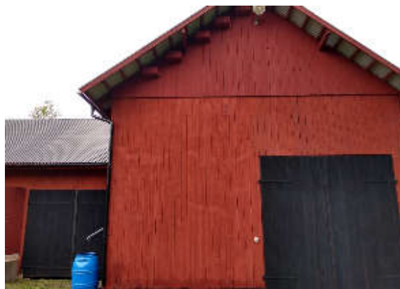
När ladutak läggs om ersätts ofta takpannor med plåttak som inte ger utrymme för tornseglare. Detta kan lätt åtgärdas genom att sätta upp holkar. Foto: Erik Thomke
