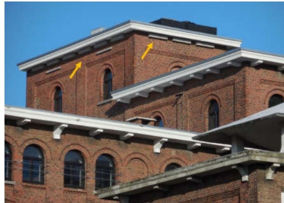
Holkar i träbetong på en byggnad i Belgien. Foto: Martine Wauters
