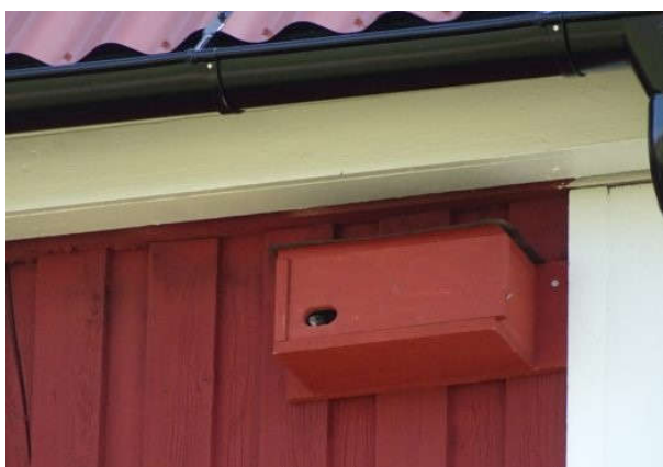
Vid en takomläggning försvann boplatser där tornseglare häckade under takpannorna. Holkar sattes upp som ersättning: Lyckat satsning! Tornseglarna flyttade in och här tittar en ut. Foto: Debora Arlt.
