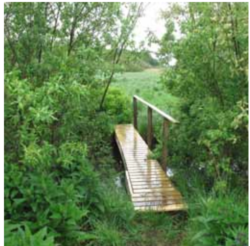
Nybyggd bro över diket! Maj 2011.
