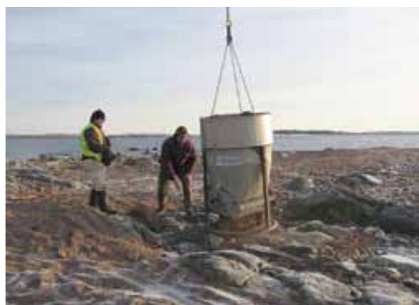
Stenarna 19 december 2007. Här styr och tömmer Ulrik Lötberg och Per Nordkvist tunnan med grus. När tunnan var tömd gällde det att snabbt fördela ut gruset med spadar och krattor innan nästa tunna anlände.
